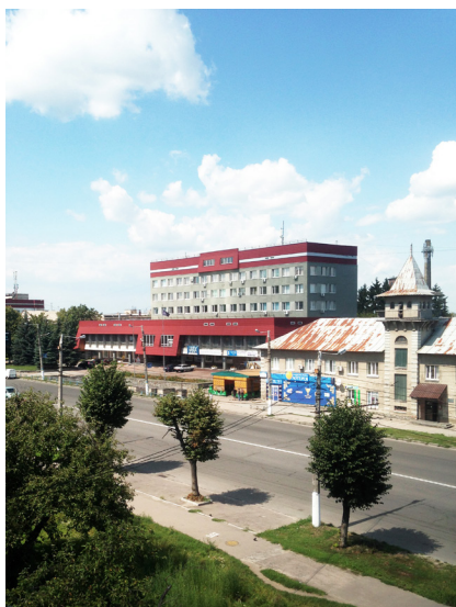
1 Будівля підприємства ТМ «Легка хода», що розташоване у північно-західній частині міста (проспект Миру, 16) / Джерело: фотоматеріали В.Тимінського (знімок 2016 року)
