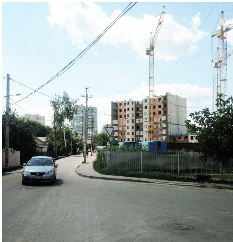
рис.7. Будівництво багатоквартирного житлового комплексу по вул. Вільський Шлях у північно-західній частині міста / Джерело: фотоматеріали В.Тимінського (знімок 2016 року)
